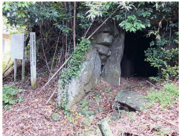
雷鬼の岩屋古墳 石室入口現況 羨道部は露出しており、東側腰壁石が内側に倒れている。
